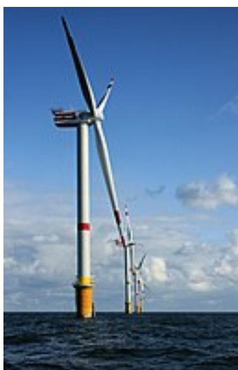
(a) Éolienne off-shore, le modèle RePower 5M a un rotor de 126m de diamètre pour une puissance de 5MW
